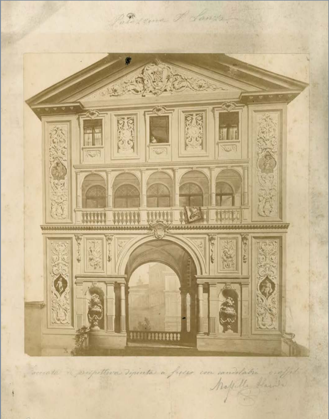
Positivo monocromo raffigurante la Palazzina F. Lanza, in particolare la Facciata di prospettiva dipinta a fresco con candelabri graffiti, firmato Mossello Placido in basso a destra, s.d. (MC_732).
